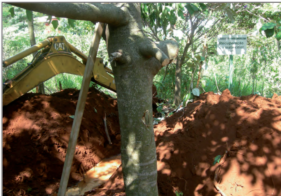
Obras SAAE – Trator em ação – 2009.
