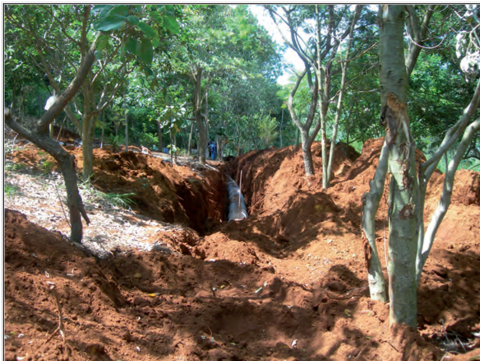
Obras SAAE – 2009 – Emissário de esgoto.
